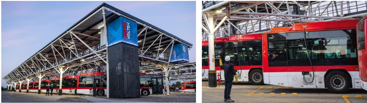
► Charging infrastructure El Conquistador depot in Santiago de Chile. Source: Red Metropolitana de Movilidad and Revista "En Concreto".
