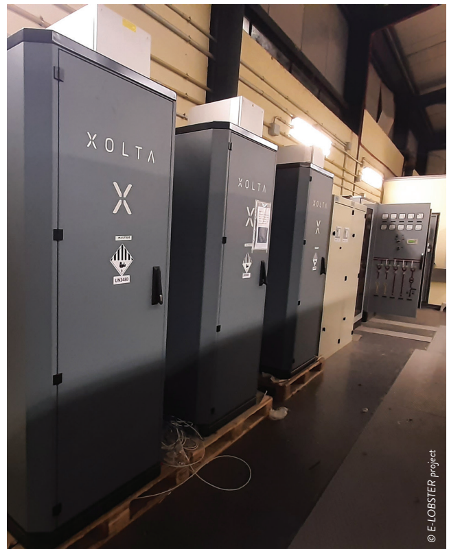
Figura 4: sistema di batterie modulari Lithium Balance (XOLTA)
